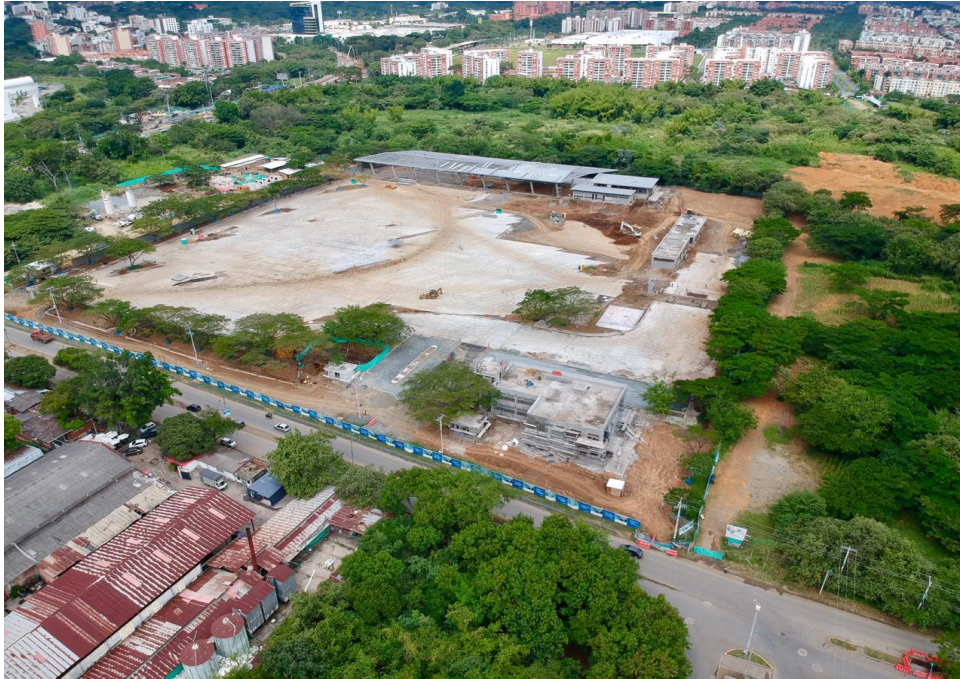
Figura 8 Patio Taller Valle del Lili/Sur ubicado en la Carrera 109 entre Calle 25 y 42.
