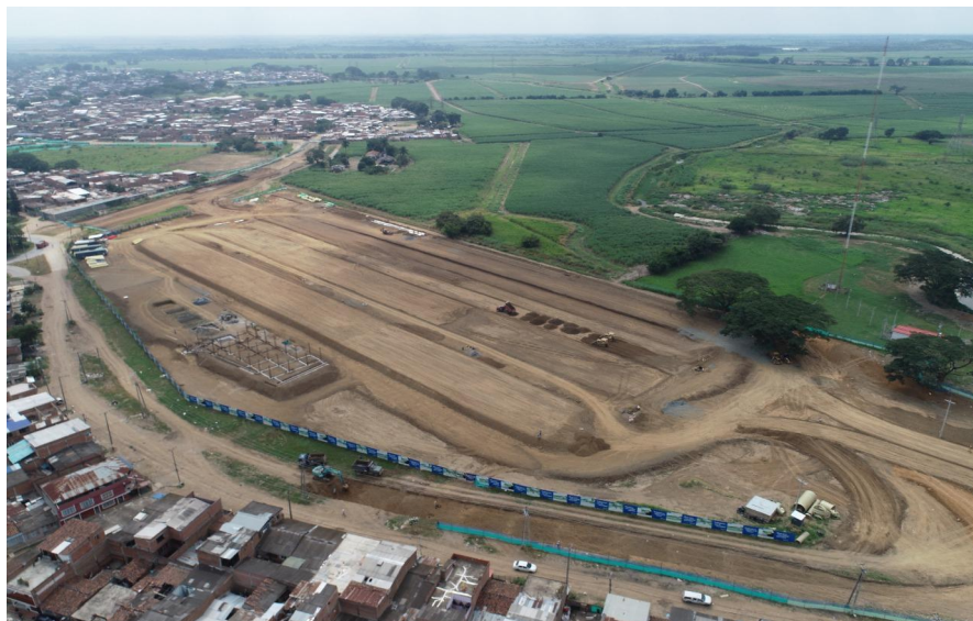
Figura 5 Terminal de Aguablanca ubicada en la carrera 28D entre calle 96 y Transversal 103 al oriente de la ciudad.
